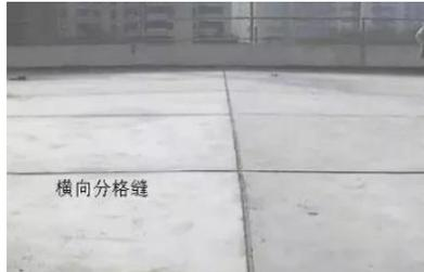
(3) 找平层设置的**分格缝可兼作排汽道**，排汽道的宽度宜为 40mm，排汽道应**纵横贯通**，并与大气连通的排汽孔相通。排汽道纵横间距宜为**6m**，屋面面积**每 36m<sup>2</sup>**宜设置一个排汽孔。
