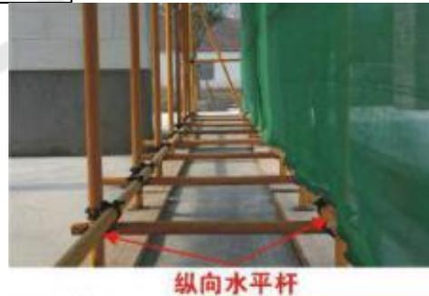
⑤纵向水平杆接长应采用**对接扣件连接或搭接**。两根相邻纵向水平杆的接头**不应设置在同步或同跨内**;不同步或不同跨两个相邻接头在水平方向错开的距离**不应小于500mm**;各接头中心至最近主节点的距离**不应大于纵距的1/3**。搭接长度**不应小于1m**,应等间距设置**3个**旋转扣件固定,端部扣件盖板边缘至搭接纵向水平杆杆端的距离**不应小于100mm**。
