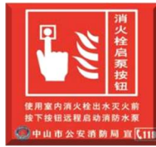
消防栓启泵按钮
